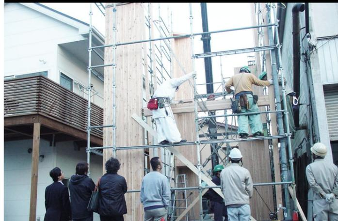
長さ9MのL字の壁柱をクレーンで吊り基礎に差し込んでいく
