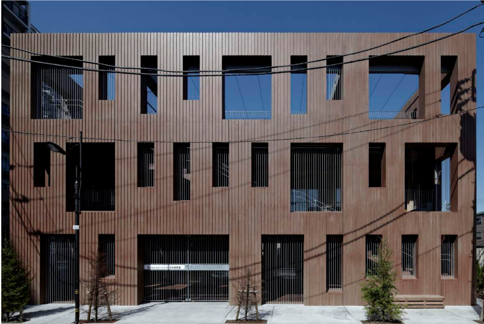
南側外観:壁に刻まれた多くの壁には、開口部の汚れ軽減、伸縮目地、木を連想させるテクスチャーなど、複合的な機能を持たせた
