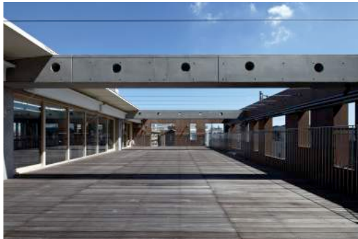
3階:屋上テラス
