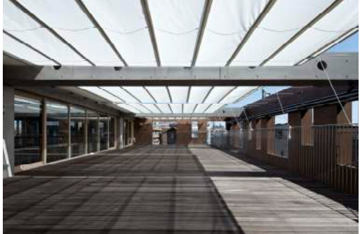
3階:テント膜によって音、陽射しを制御する
