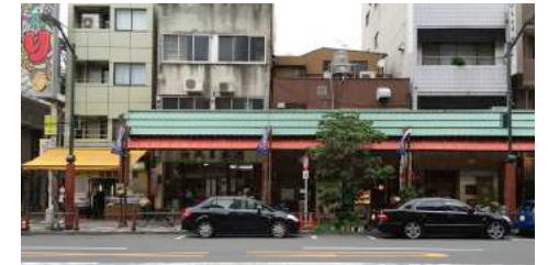
改修前の外観は緑と朱の2色で構成
