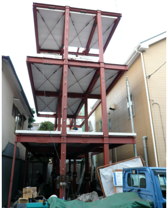
外周部に柱のない鉄骨造の構造
