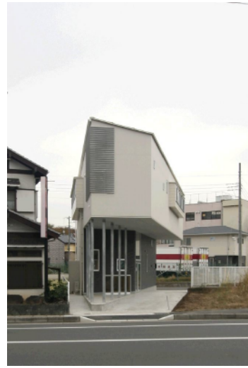
間口を広く開け、車の進入・通り抜けを考慮した。
