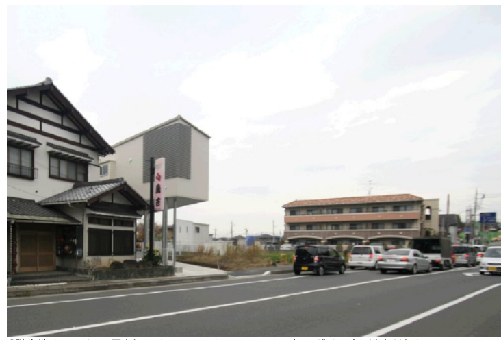
2階先端はルーバーで囲まれたバルコニーになっている。その奥に、眺めの良い浴室がある。
