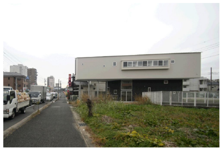
水平性を強調する長い出窓。勉強机になっており、光を内部に取り込む。
