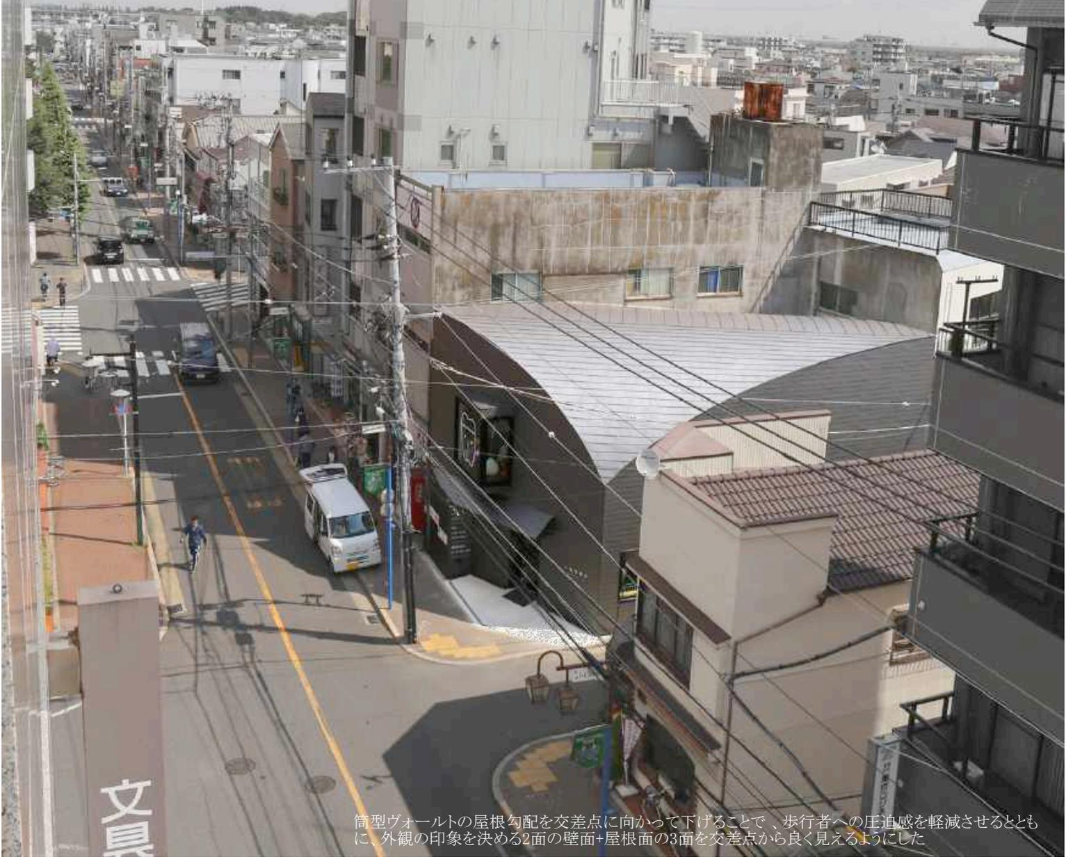
筒型ヴォールトの屋根勾配を交差点に向かって下げることで、歩行者への圧迫感を軽減させるとともに、外観の印象を決める2面の壁面+屋根面の3面を交差点から良く見えるようにした
