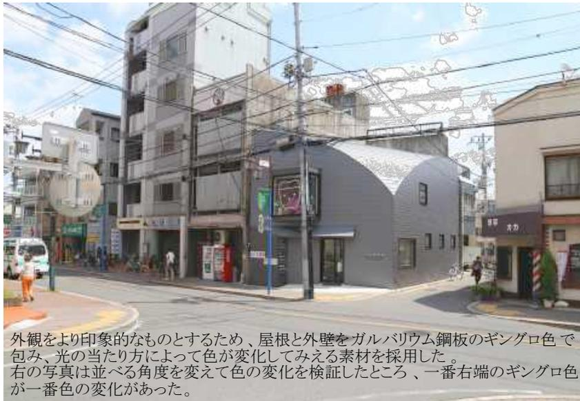
外観をより印象的なものとするため、屋根と外壁をガルバリウム鋼板のギングロ色で包み、光の当たり方によって色の変化してみえる素材を採用した。右の写真は並べる角度を変えて色の変化を検証したところ、一番右端のギングロ色が一番色の変化があった。
