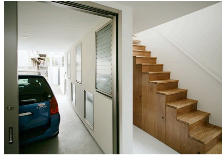
内部から見た1階アプローチスペース。必要な耐力壁と窓を重々しくならないように千鳥に配置。
