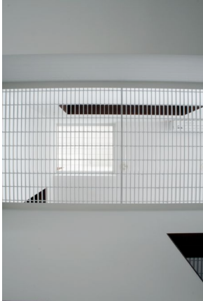
1階から3階までの吹き抜け
