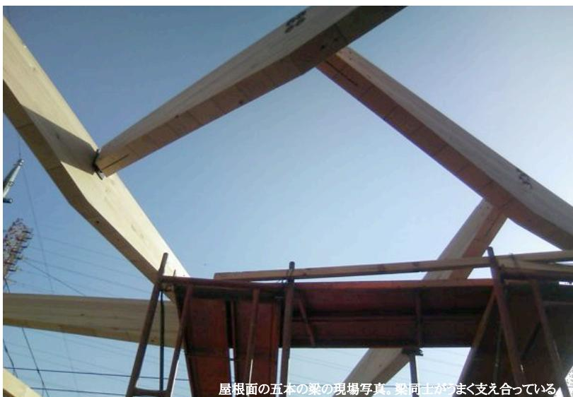
屋根面の五本の梁の現場写真。梁同士がうまく支え合っている。
